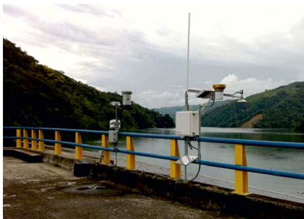
Figura 8: Estaciones de telemetría radial y satelital.
