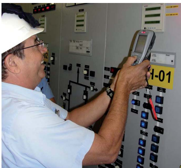
Figura 11 – Operador executando sua inspeção e lendo o código de barras.
