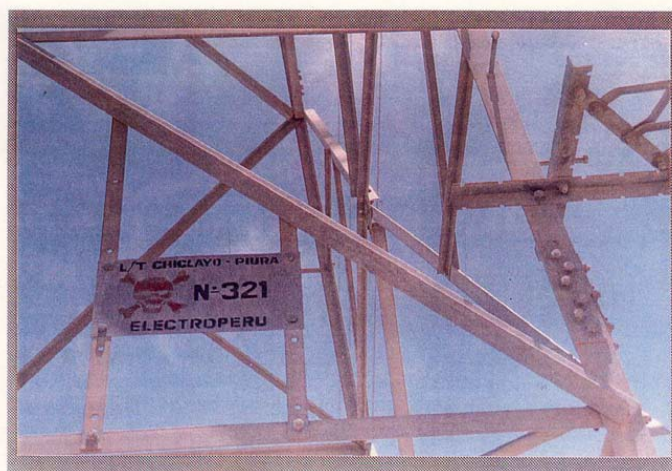
Figura 1: NIVEL DE CORROSION 1
