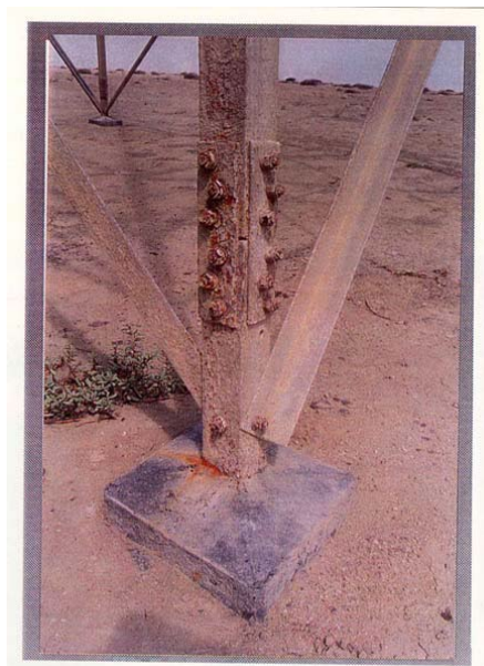
Figura 3: NIVEL DE CORROSION 3
