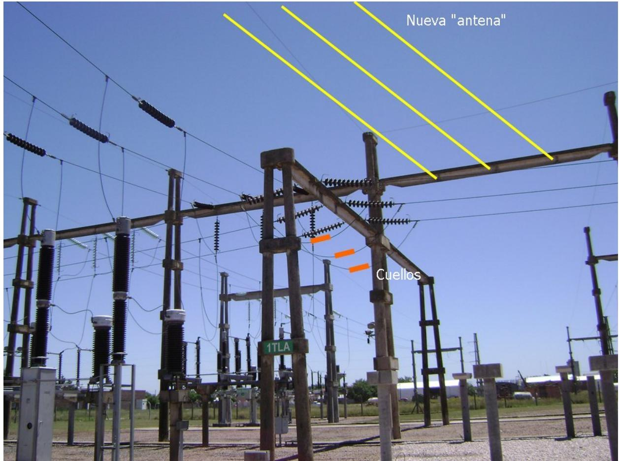
En la figura anterior se muestra el corte de los cuellos muertos (color fucsia) y luego como se tendería la nueva antena (color amarillo) para conectar al transformador (N°6) de 132/33/13,2 kV.
